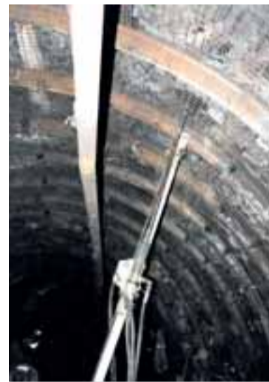
Vrtací stroj ke svorníkování.
