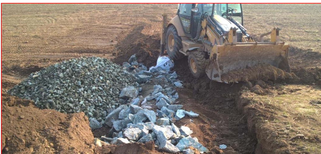
Obr. 7 Překrytí velkoobjemových vaků zeminou (ohumusování) a realizace kamenného záhozu v místě přepadu přehrážky
