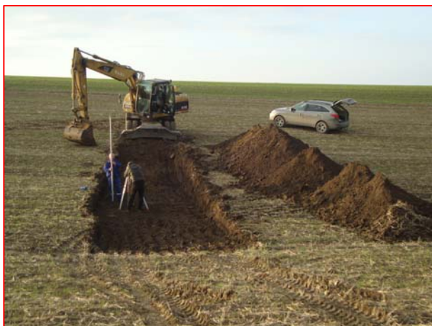
Obr. 4 Zahájení zemních prací
