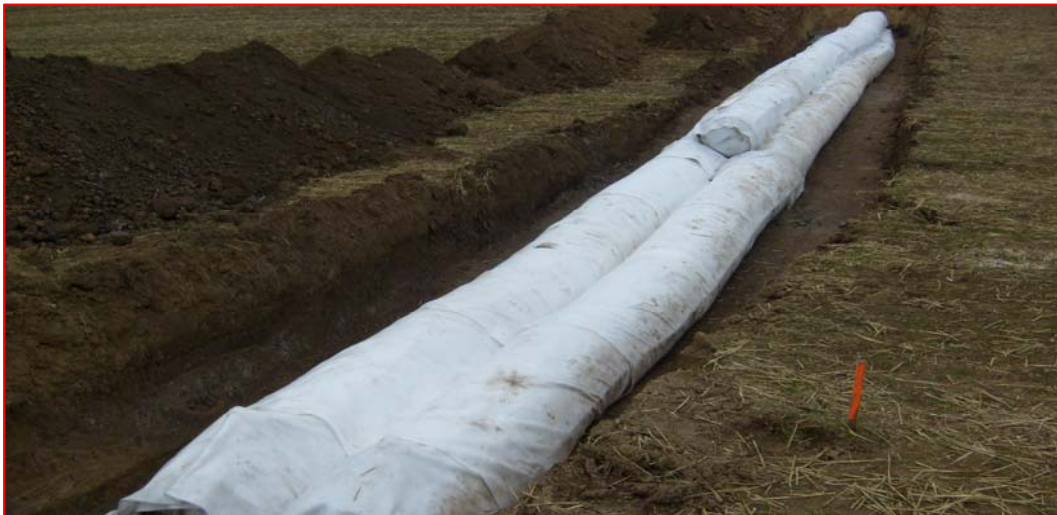
Obr. 6 Dokončená instalace velkoobjemových vaků jakožto stabilizačního prvku přehrážky
