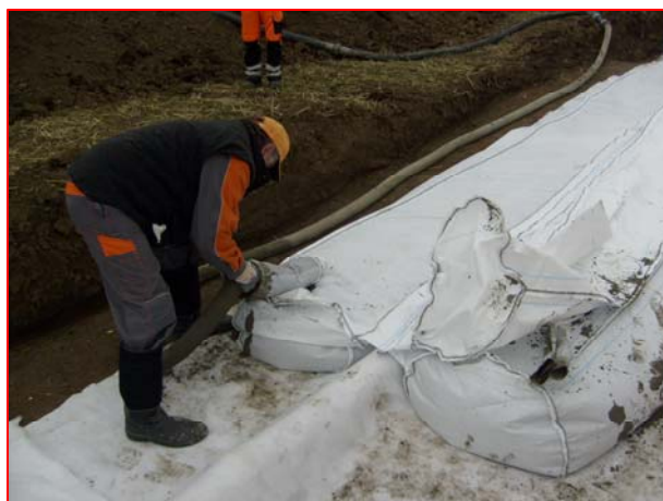
Obr. 5 Plnění velkoobjemových vaků plnicí směsí
