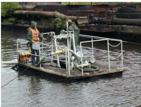
Čerpání okují čerpadlem KTX 80 umístěného na pontonu
