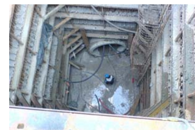
Provádění injektáže betonového ostění pomocí čerpadla KTX 32 N
