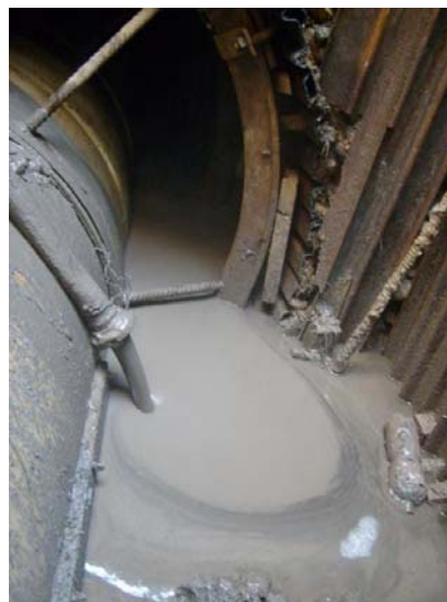
Vytékání cementopílkové směsi z hadice "B" do prostoru štolý kolem roury HOBAS
