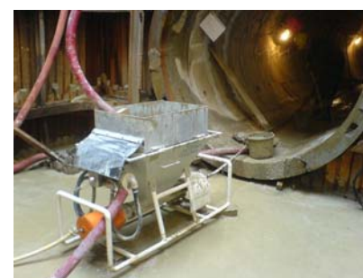
Provádění injektáže betonového ostění pomocí čerpadla KTX 32 N
