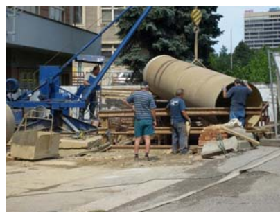
Spouštění roury HOBAS do šachty Š 50N1
