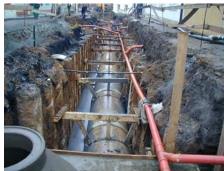
Částečně zalité potrubí HOBAS popílkocementovou směsí ve výkopu
