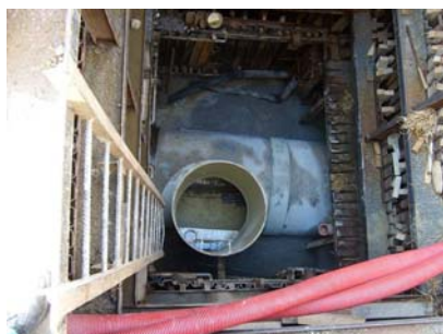
Pohled do šachty Š 50N1 před úplným zalitím rour HOBAS cementopílkovou směsí
