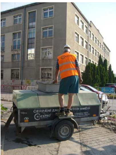
Částečně zalité potrubí HOBAS popílkocementovou směsí ve výkopu
