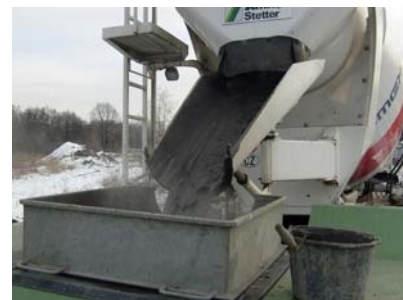
Vysypávání popílko-cementové směsi z domíchávače do násypky KTX 125
