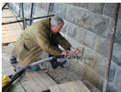
Injektování přehradní hráze přes vrty
