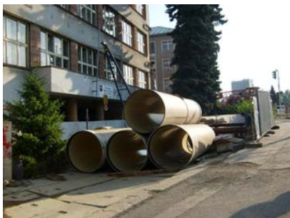
Připravené roury HOBAS, průměr 1 400 mm na vtažení do štolý
