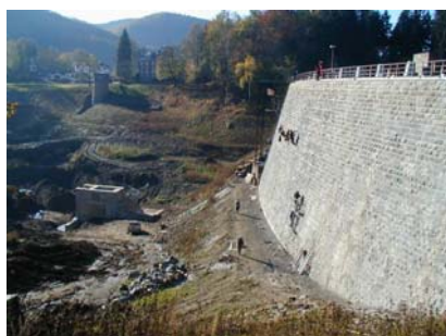
Injektování dutin v hrázi přes injektážní vrty
