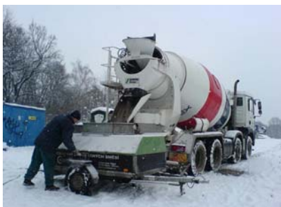
Čerpání popílko-cementové směsi do mezikruží kanalizačního sběrače
