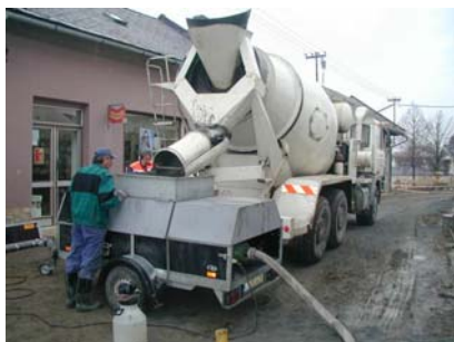
Plnění vřetenového čerpadla KTX 125 popílkocementovou směsí z domíchávače
