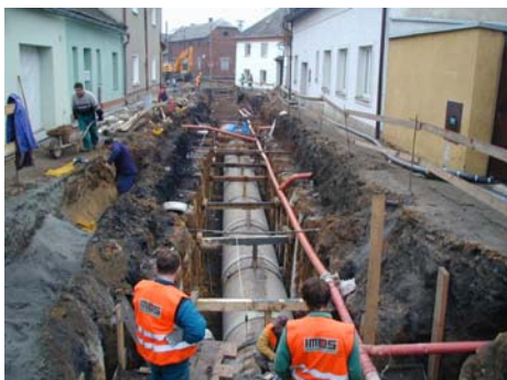
Příprava potrubí HOBAS ve výkopu před zalitím popílkocementovou směsí
