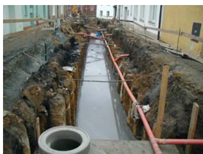
Zalité potrubí HOBAS popílkocementovou směsí ve výkopu
