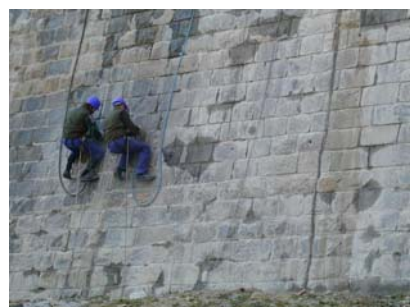
Injektování dutin v hrázi přes injektážní vrty
