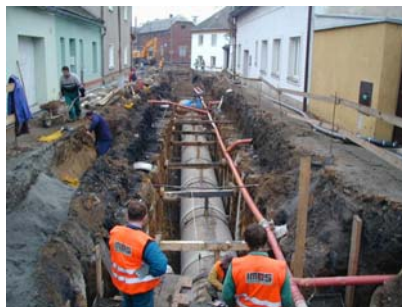
Příprava potrubí HOBAS ve výkopu před zalitím popílkocementovou směsí
