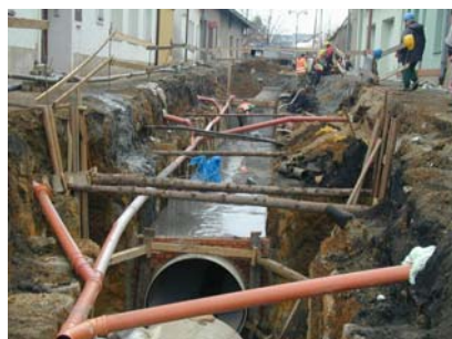
Zalévání potrubí HOBAS popílkocementovou směsí přes čerpadlo KTX 125
